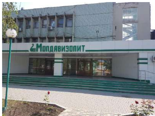
Рис. 1. Общий вид здания
