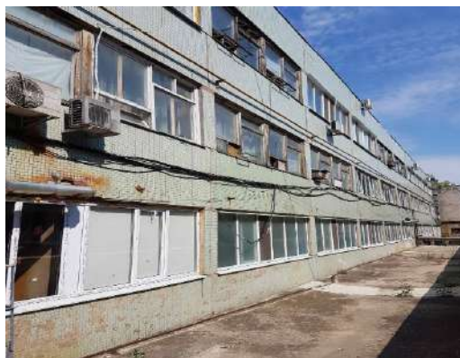
Рис. 3. Вид на стены и окна
