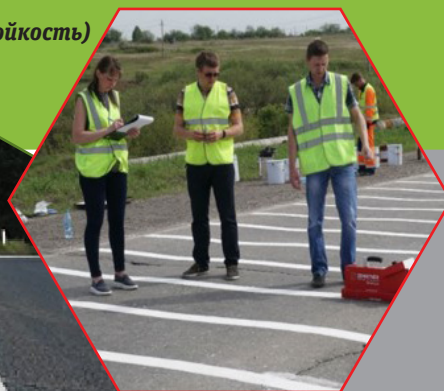
Разметка холодным пластиком
