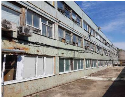
Рис. 3. Вид на стены и окна
