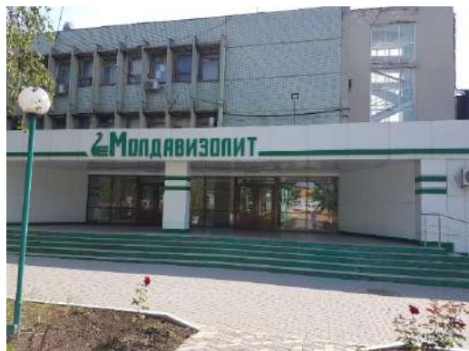
Рис. 1. Общий вид здания
