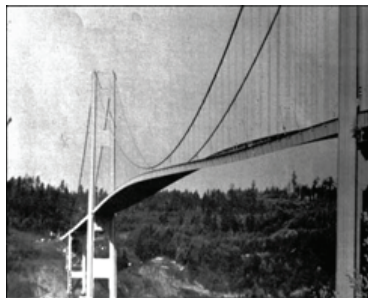
Рис. 2. Такомский мост при деформации
